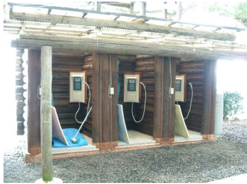
温水シャワー完備
